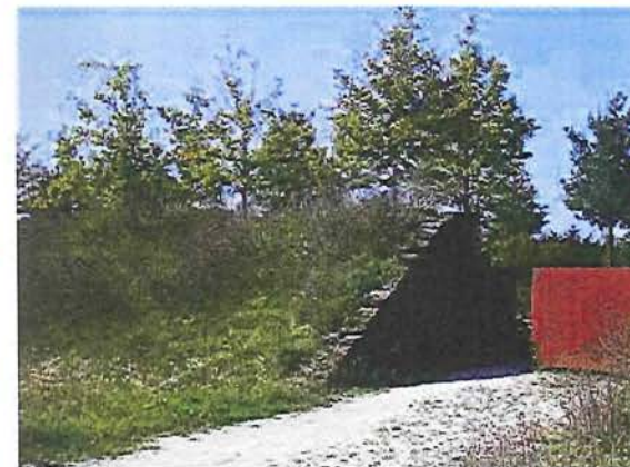
Taluds met beplanting langs randen groene wig
