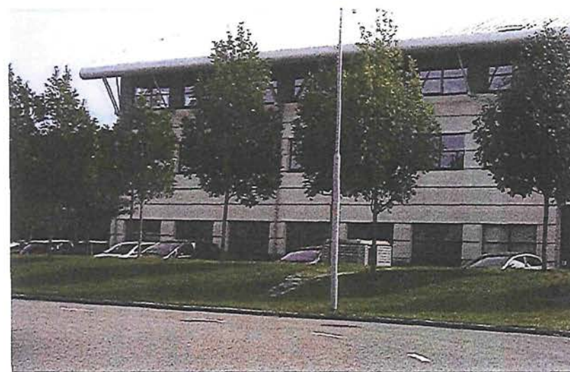
parkeren en opslag 'verstopt' achter een talud
