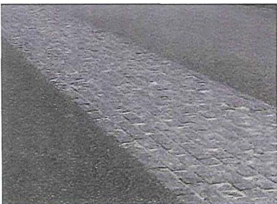
Ontsluitingsweg: asfalt met rammelstrook
